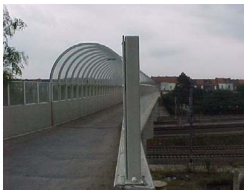
Foto 5.74 en Foto 5.75 Ongelijkvloerse kruising van een voetweg en een spoorbaan
