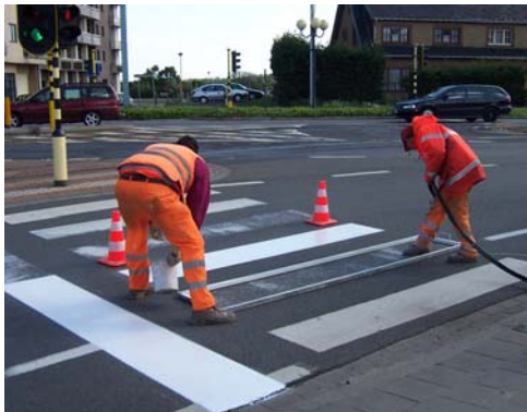
Foto 6.2 en Foto 6.3 Onderhoud voetgangersoversteekvoorzieningen
