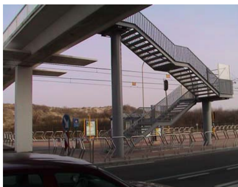
Foto 5.76 en Foto 5.77 Ongelijkvloerse kruising middels een voetgangersbrug
