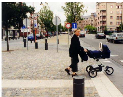
Foto 5.38 en Foto 5.39 Noppentegels met een kunstmatige geleidelijn (uitgevoerd in ribbeltegels) aan oversteekplaatsen
