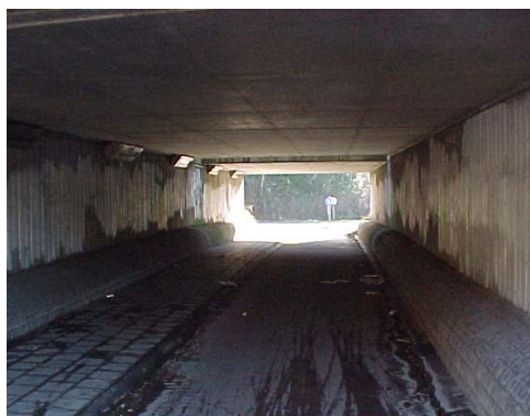
Foto 5.81 Tunnel voor voetgangers en fietsers
