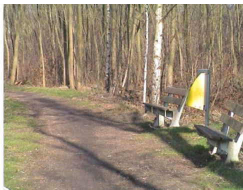
Foto 5.14 Toepassing van bitumineuze verharding voor een wandelpad
