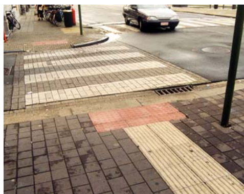
Foto 5.38 en Foto 5.39 Noppentegels met een kunstmatige geleidelijn (uitgevoerd in ribbeltegels) aan oversteekplaatsen
