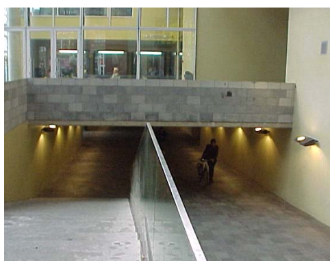
Foto 5.82 Verlichting van tunnels
