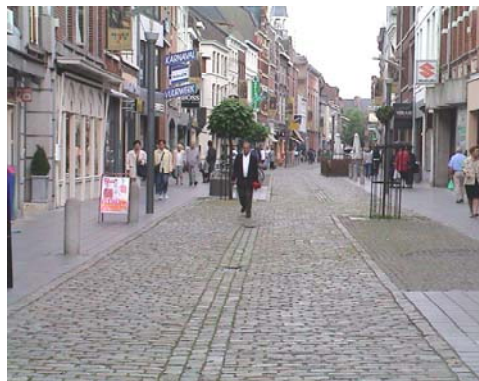
Foto 5.17 Toepassing van elementen in natuursteen als verharding van een voetpad
