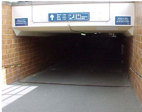
Foto 5.84 Toegankelijkheid van tunnels
