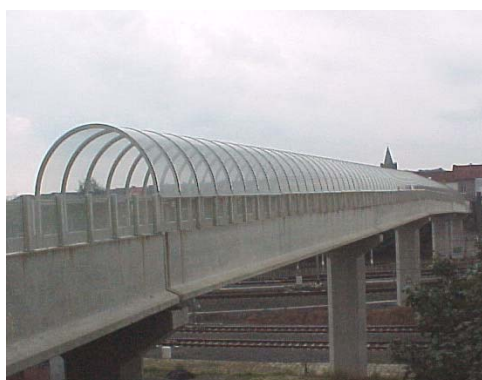
Foto 5.78 Brug met bescherming tegen weer en wind
