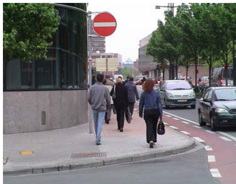
Foto 2.14 Voorbeeld van voetgangersvoorzieningen langs een verkeersweg
