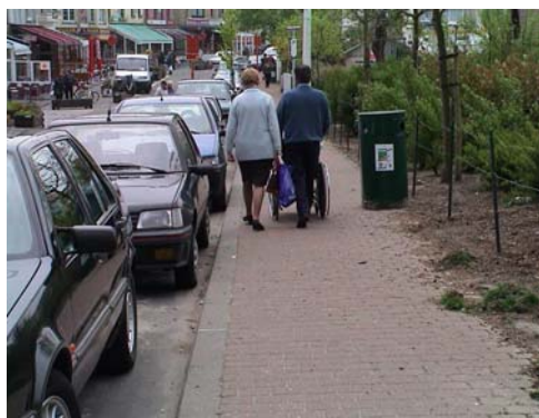
Foto 3.1 en Foto 3.2 Voetpad met minimale obstakelvrije ruimte
